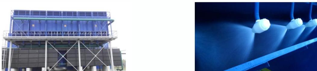
Рис. 1. Модульная эжекционная безвентиляторная градирня
